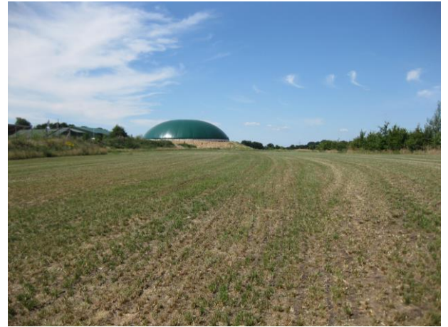
Abbildung 6: Plangebiet, links vorhandene Hecke an der nördlichen Grenze, rechts Teile der Biogasanlage.
