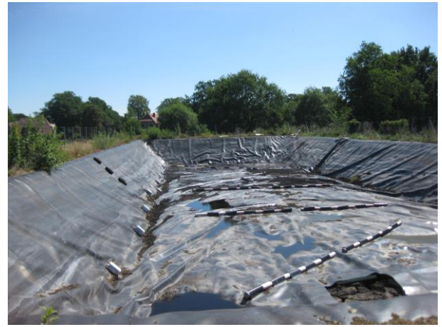
Abbildung 8: Vorhandenes Folienbecken, das im Zuge des Photovoltaikanlagenbaus zurückgebaut wird.
