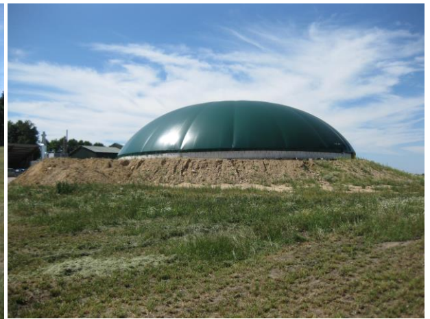
Abbildung 4: Gärbehälter mit Havariewall, die zugunsten der Photovoltaikanlage zurückgebaut werden.
