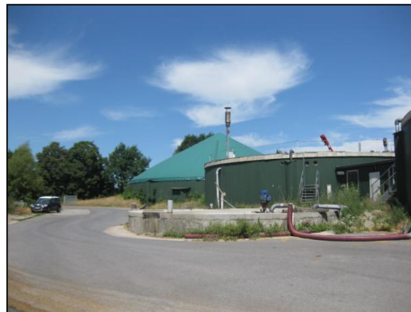
Abbildung 3: Blick von Südwesten
