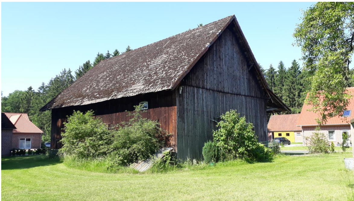
Abbildung 1-2: Die Scheune, die abgerissen werden soll
